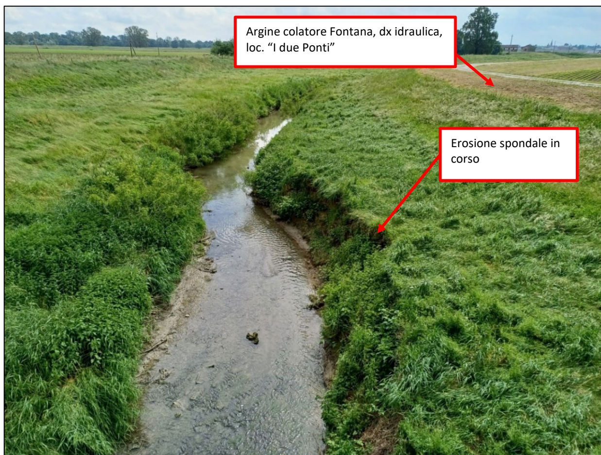
Figura 16 – Colatore Fontana: erosione spondale in corso.
